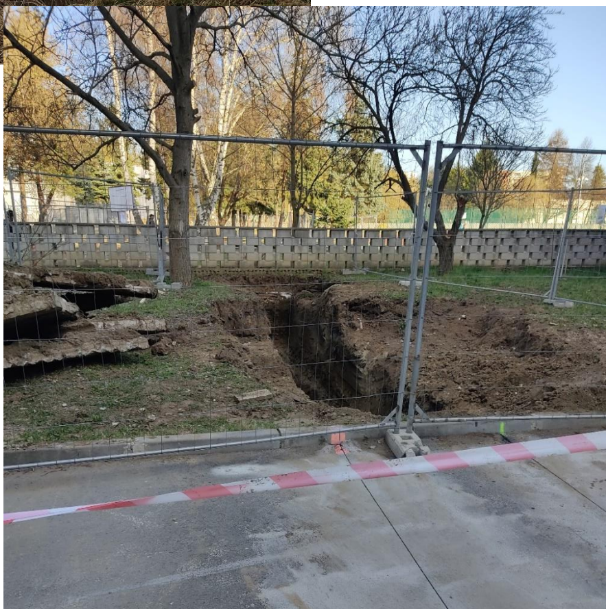
Obr. 2 – Úprava kanalizačnej siete, ulica Šmeralova. 12. 4. 2022
