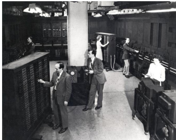
Jeden z prvých výkonných počítačov. Elektrónkový počítač ENIAC z roku 1946. Vážil 30 ton, obsahoval viac ako 17 000 elektrónok a zaberá plochu veľkej miestnosti. Bol chladený leteckými motormi a mal príkon 150 kW (bežný notebook má príkon cca 60 W, teda 2500 krát menej). Programovanie počítača spočívalo v prepájaní drôtov a nastavovaní prepínačov, čo mohlo trvať od pol hodiny až po jeden deň.
